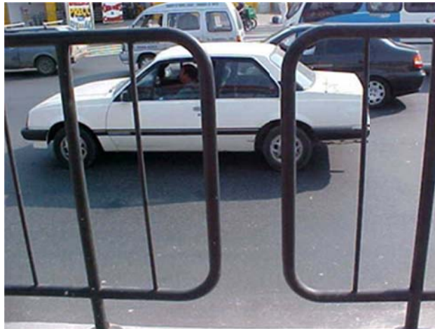
O espaçamento excessivo entre módulos torna o gradil ineficiente, por permitir a passagem em locais inadequados.
