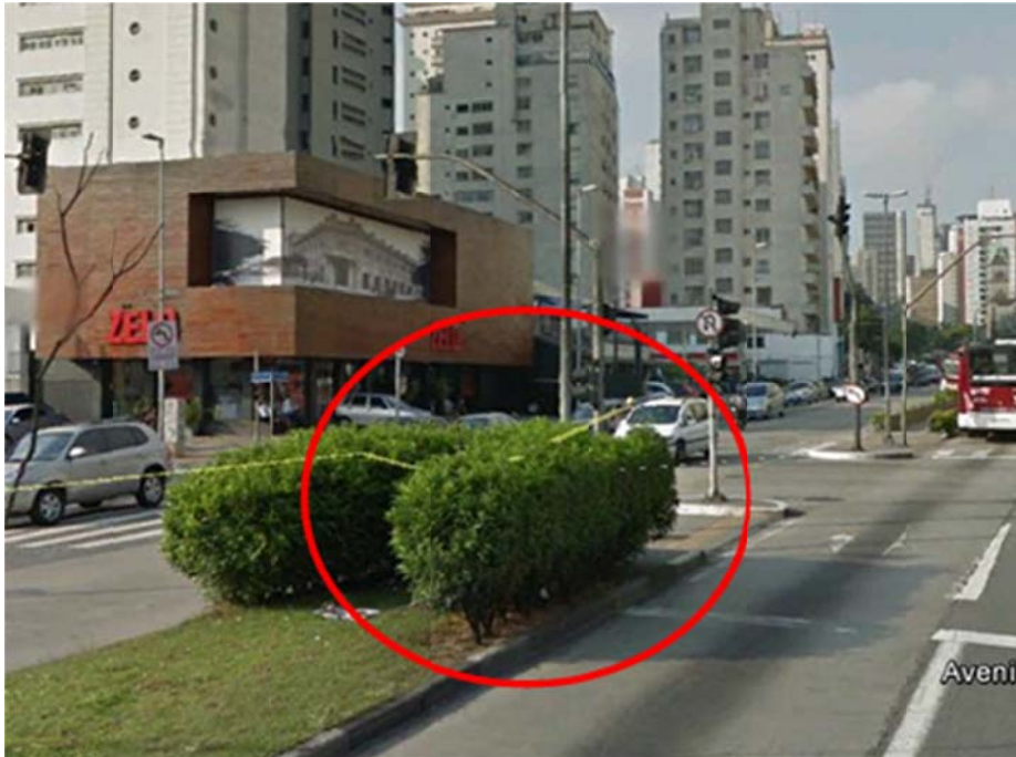
Arbusto na proximidade da travessia obstrui a visibilidade entre pedestres e motoristas
