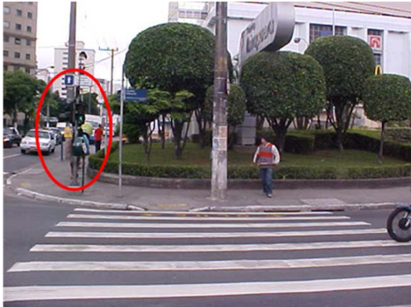
Foco posicionado fora da área da faixa, mal pode ser visto por quem aguarda a travessia
