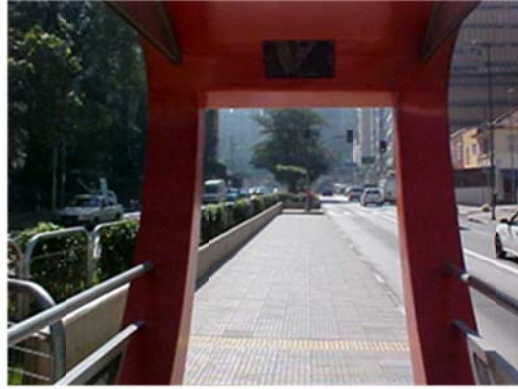
Local B: situação final : vegetação removida, piso pavimentado e criação de acesso devidamente canalizado até à faixa de travessia mais próxima.
